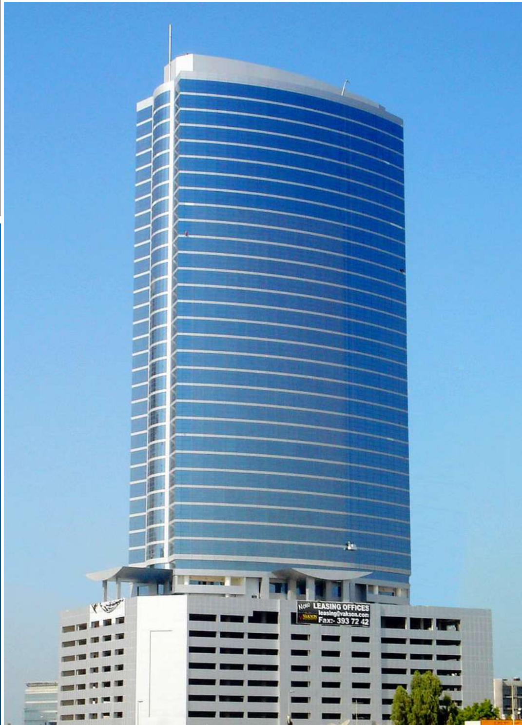
■ Shatha Tower, U.A.E
